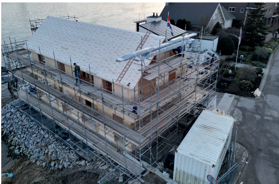
Woning in Ouderkerk aan de Amstel in aanbouw. Met verspringende gevelvlakken en een markante daklijn laat het ontwerp de mogelijkheden van CLT zien.
