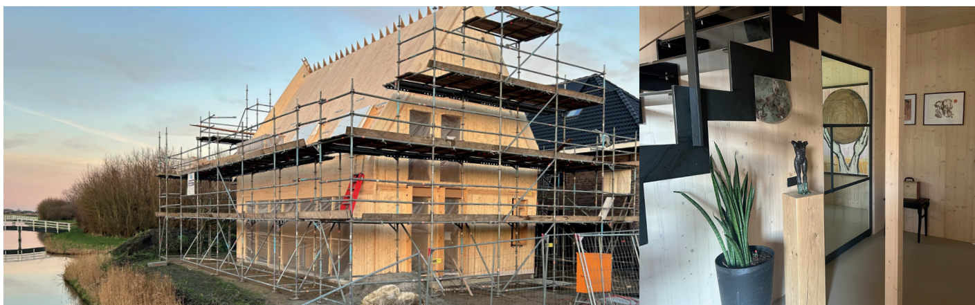
Moderne schuurwoning in aanbouw door iWood in Berkhout (januari 2026) en impressie interieur (hal van de woning, juni 2026).
