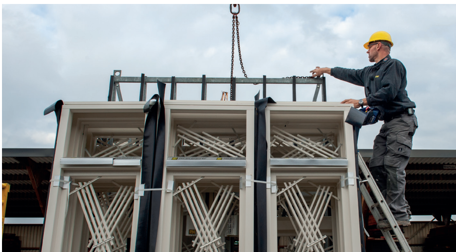
Kozijnen, klaar voor transport naar de bouw.
