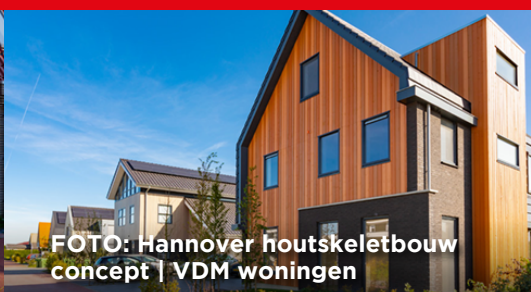
FOTO: Houtskeletbouwwoningen | VDM woningen
