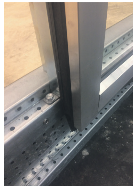
▲ Afbeelding 5. Voorbeeld van een circulaire bouwwijze met staal. Hier het Skellet systeem met een Janssen gevel die in een testmarkt al 'as a service' is geleverd. De leverancier blijft eigenaar. Het Skellet systeem ademt het welbekende Meccano waarmee wij vroeger als kind al circulaire bouwden.
