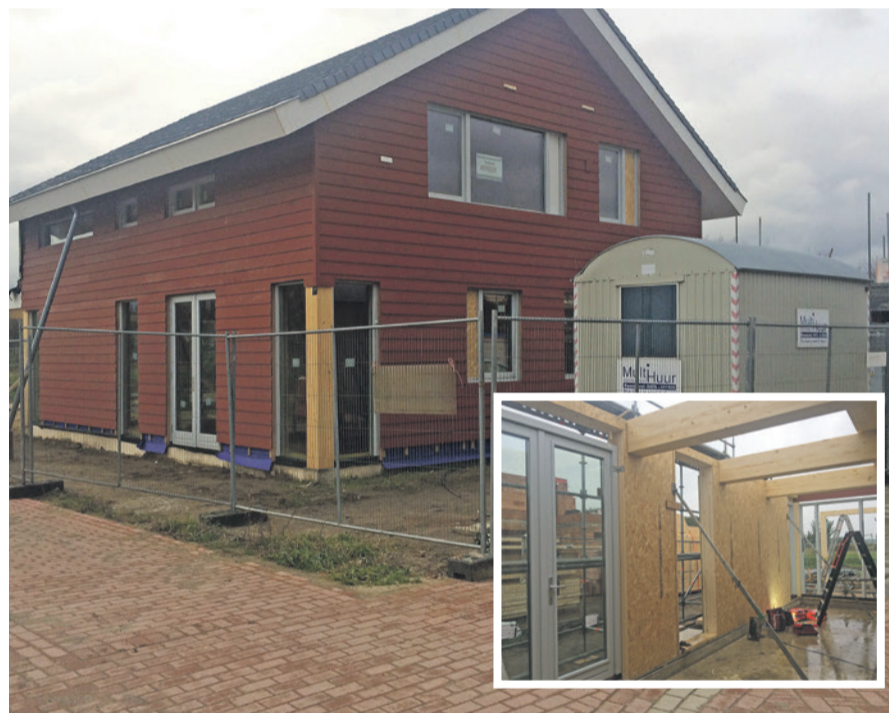
▲ Afbeelding 4. Eind 2019 is in samenwerking met Houtbouw 't Zand gestart met de realisatie van een HSB woning, ontwikkeld in Slimbouwen en conform Active House. De woning bevat in gewicht per m 2 nuttig vloeroppervlak minder dan 300 kg materiaal. Bij traditionele bouw in beton en steen is dit circa 1.500 kg: een besparing van 80%. In het hout is ruim 17 ton CO 2 opgeslagen. Het zomerklimaat wordt beheerst door reductie van de binnenkomende warmte (onder andere screens en parasoldak) en met gestuurde nachtventilatie in een samenwerking met Duco en Velux.
