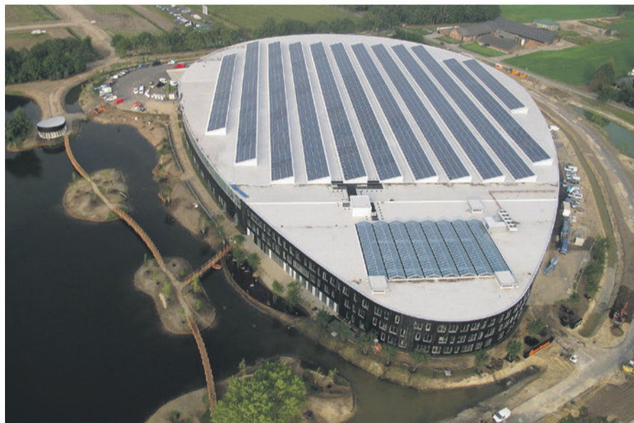
▲ Afbeelding 2. De Venco Campus te Eersel is één van de zuiver uitgevoerde Slimbouwen projecten. Resultaat: een hoger kwaliteitsniveau met Breeam Outstanding predicaat, een gewichtsreductie van 50%, halvering van de bouwtijd en dat alles bij een besparing op bouwkosten van 30%.
