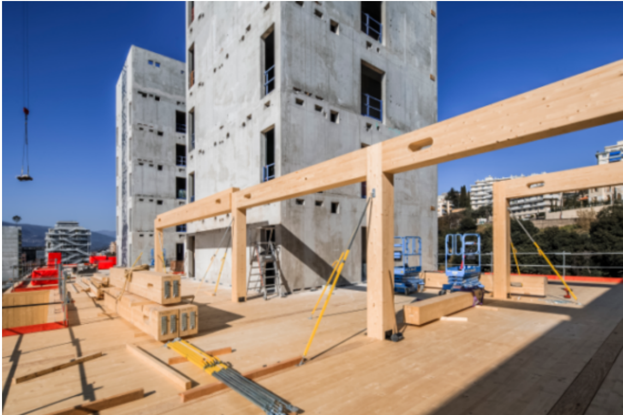
Combinatie van hout (glulam-liggers en CLT-vloeren) en beton in het Palazzo Merida gebouw (35m hoog) in Nice, Frankrijk.
