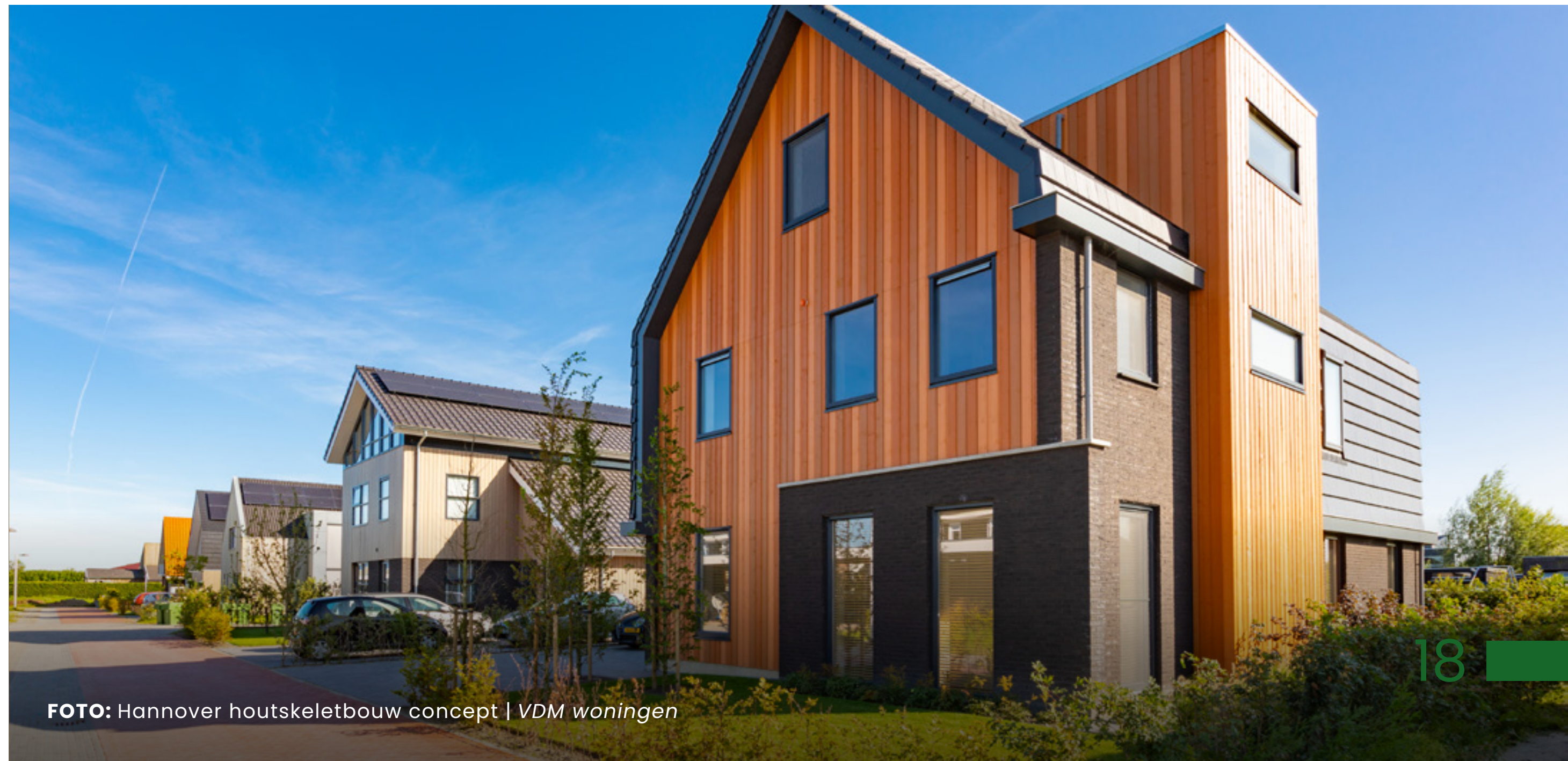
FOTO: NOW gebouw, gelamineerde spanten en houtskeletbouw gevelelementen | De Groot Vroomshoop
