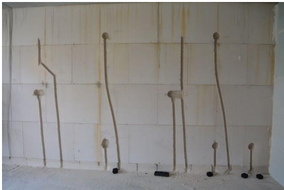
Figuur 15 Ingefreesde leidingen in kalkzandsteenwand
