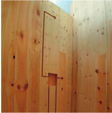
Figuur 16 gefreesde sparingen in CLT element
