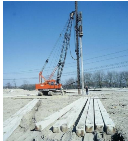
Figuur 3 proces inbrengen prefab heipalen bron: (Franki foundations, 2020)
